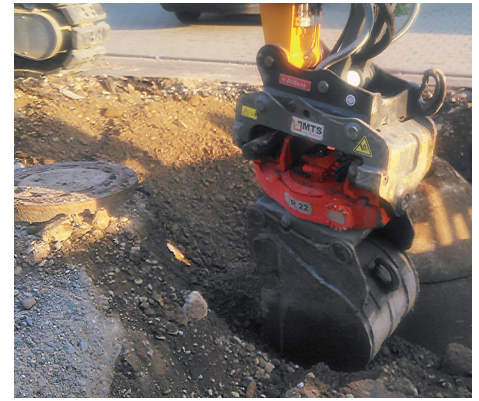
Dank seiner innenliegend verbauten Schwenkzylinder lässt sich auch bei einem 120 cm schmalen Verbau komfortabel mit dem MTS-Tiltrotator arbeiten.
